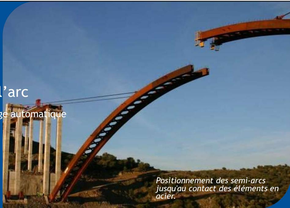
*Positionnement des semi-arcs jusqu'au contact des éléments en acier.*
