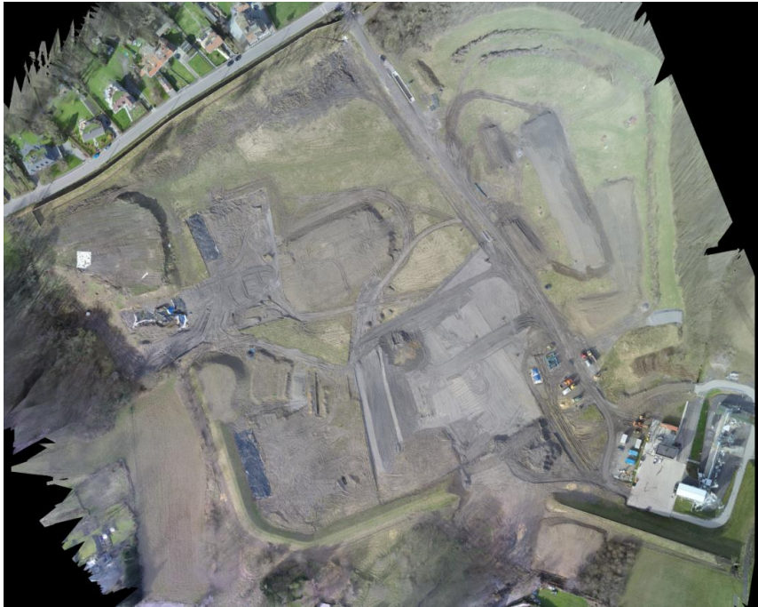
Levé au drone
